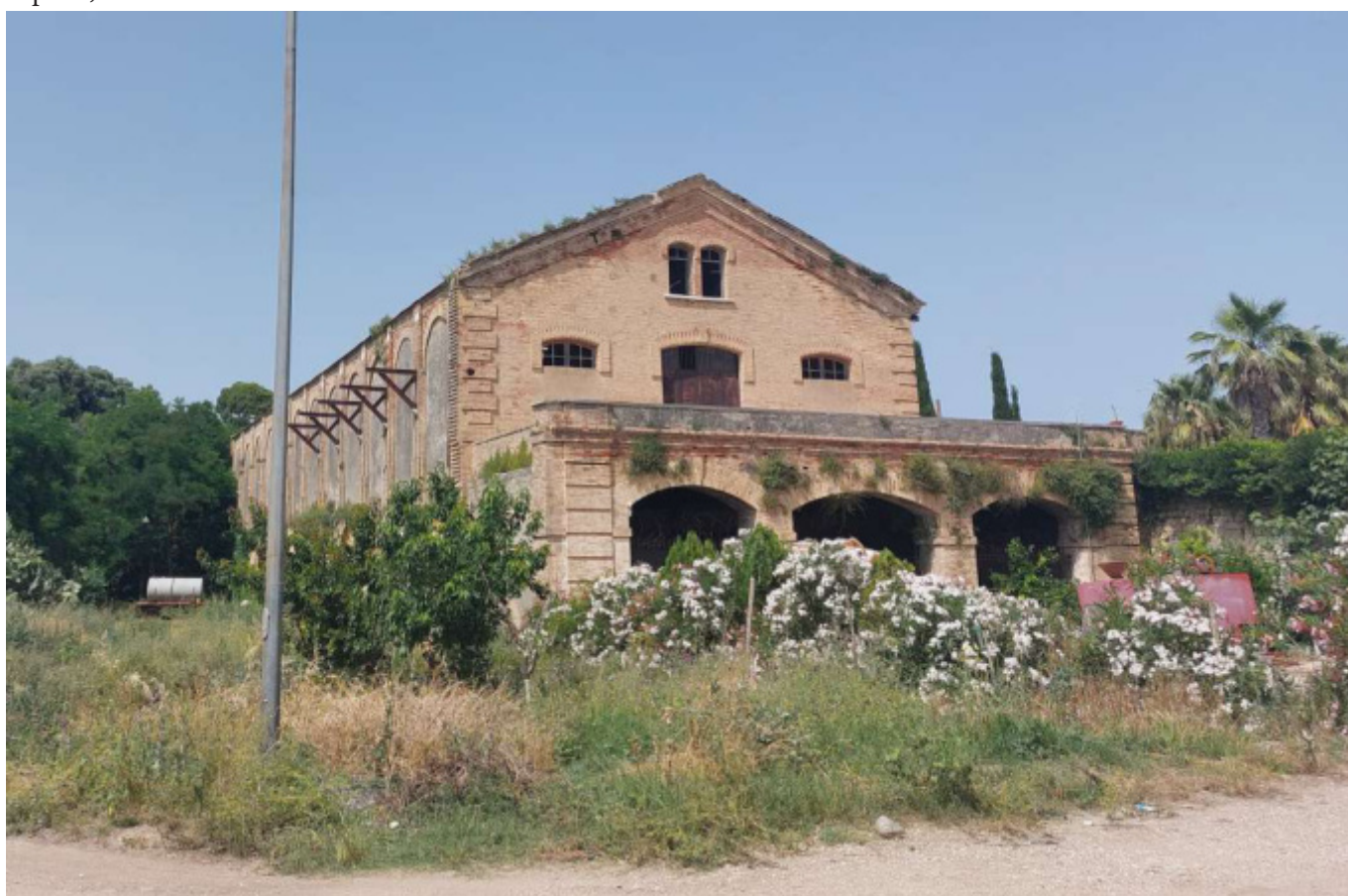
Foto 98.2 - Ripalta (frazione di Lesina), visuale sull'insediamento
